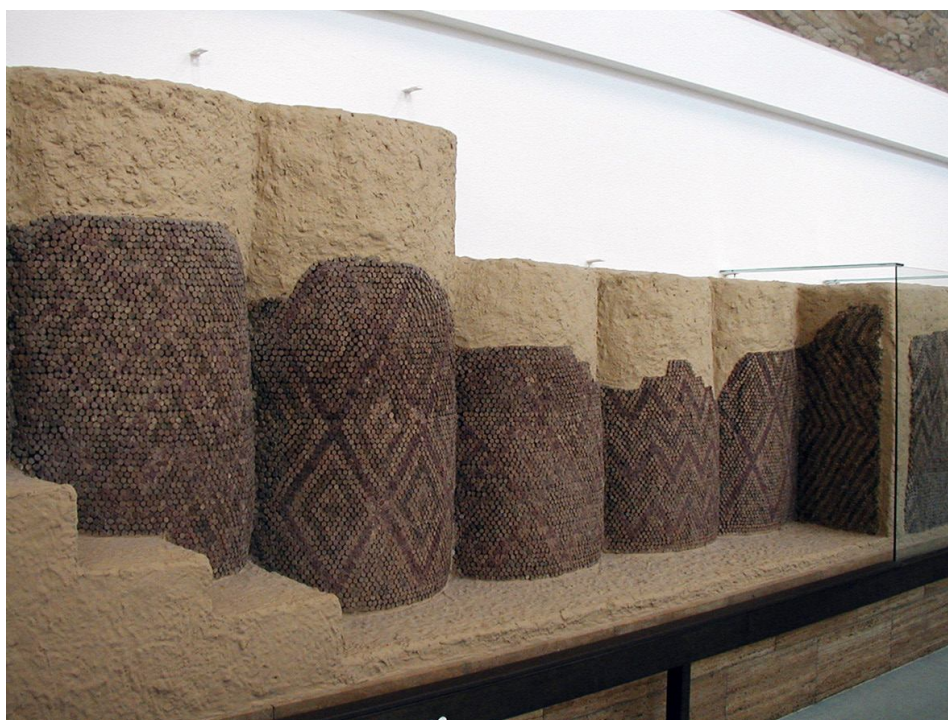
Рис. 1. Фрагменты стен с мозаикой из керамических конусов (реконструкция)
